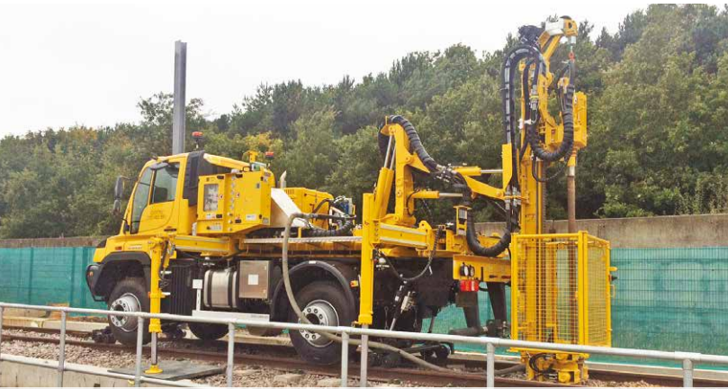
Perforatrice speciale su camion per lavori di consolidamento e sondaggi su tracciati ferroviari Special truck mounted drill rig for investigation works and ground improvement along railway lines.
